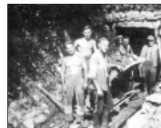
Arbeitseinsatz im Stollen bei Rohrbach im Odenwald
