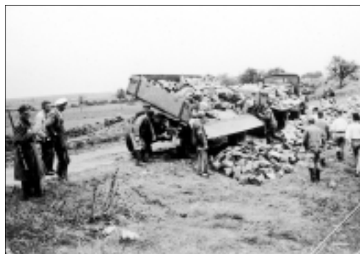
Anlieferung von Steinen aus dem Steinbruch bei Eppertshausen zur Befestigung des Bachlaufs der Gersprenz
